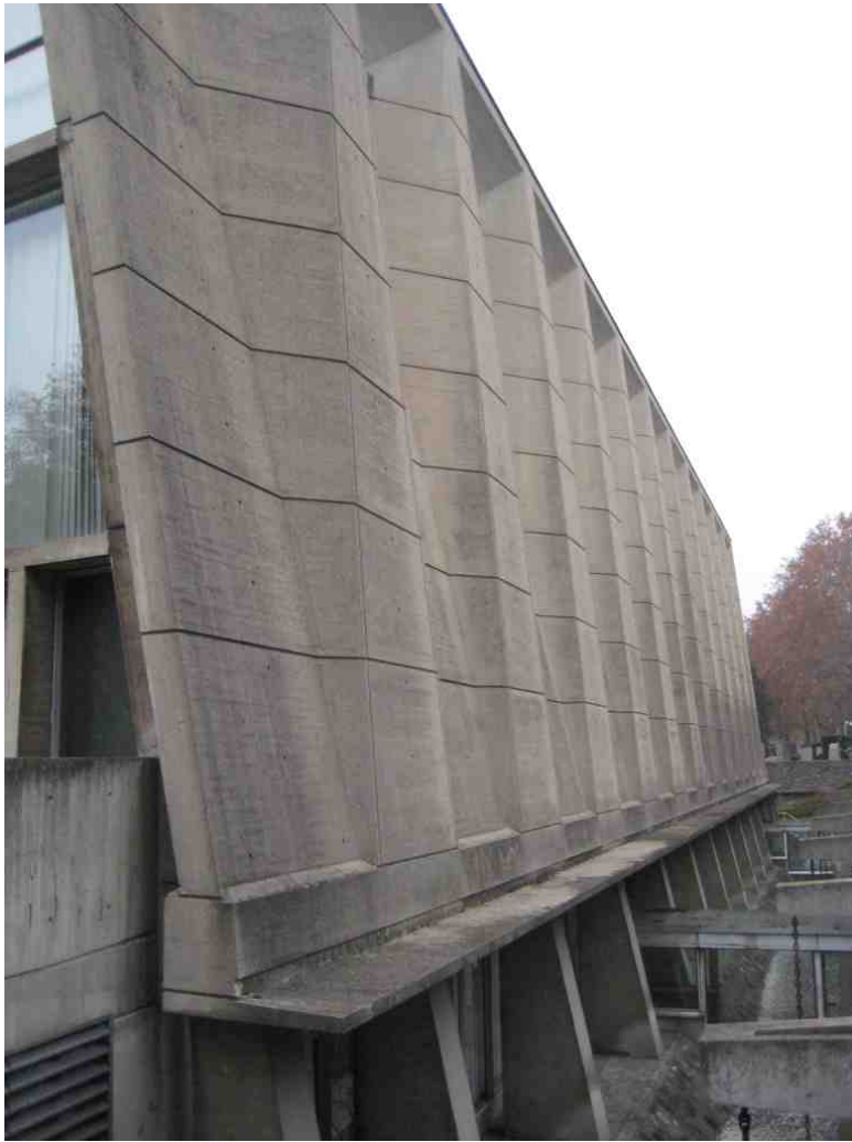
Unescobyggnaden från 1950 är ett utmärkt exempel på arkitektur inom ISC20C:s intresseområde. Bakom den veckade betongfasaden finns den stora sessionssalen och foajéer. (Foto: Britt Wisth)
