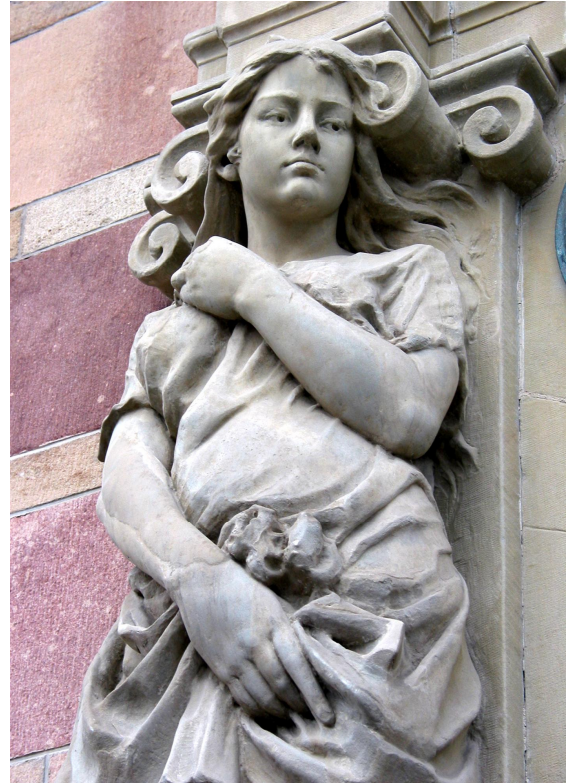
Portalutsmyckningen på Strandvägen 45 i Stockholm är formad av gotländsk sandsten. Foto: Malin Myrin, 2003
