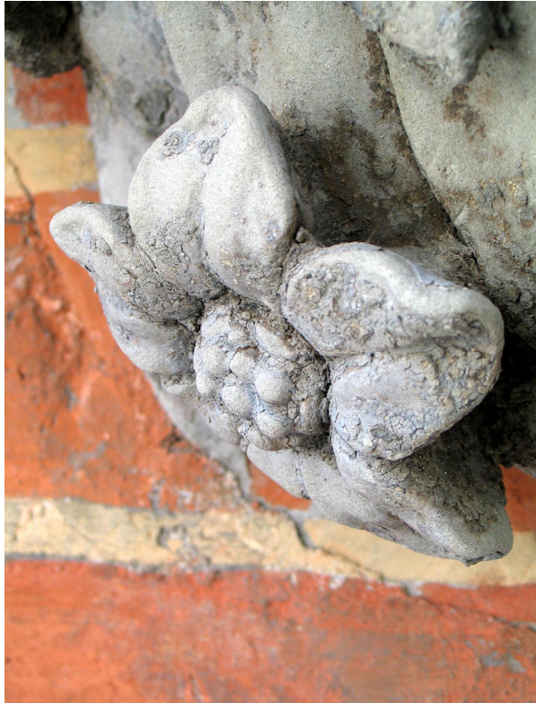
Riddarhusets oerhört detaljrika fasadutsmyckningar är formade av gotländsk sandsten. Foto: Malin Myrin, 2005
