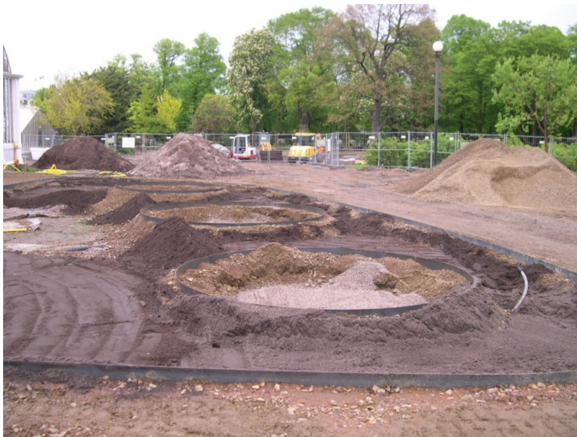
Markarbetena framför Palmhuset i Trädgårdsföreningen, Göteborg: kortenstål, fiberduk och dräneringsslangar – långt från 1800-talets trädgårdshantverk. Foto: Kjell Lundquist, 20 maj 2009.
